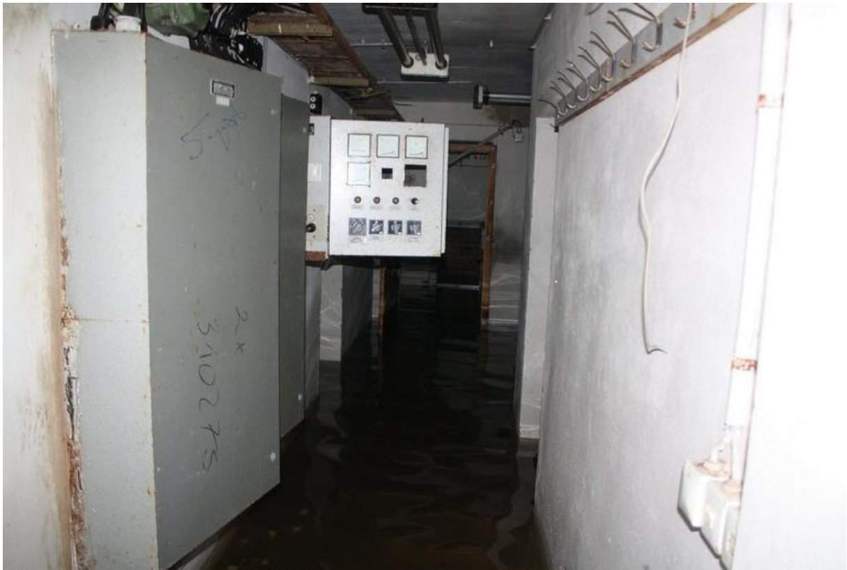
Blick in den Bunker 10/2010 Haus Seefrieden © Foto: Markus Funke
